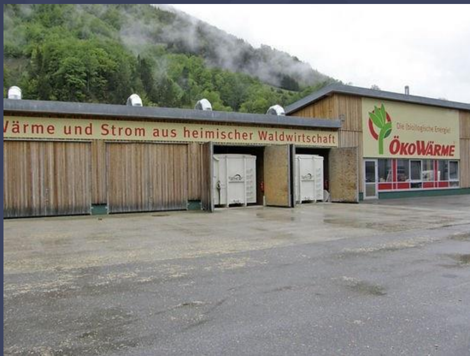
Ciepłownia wiejska Ökowärme w Reichraming ( Austria )
